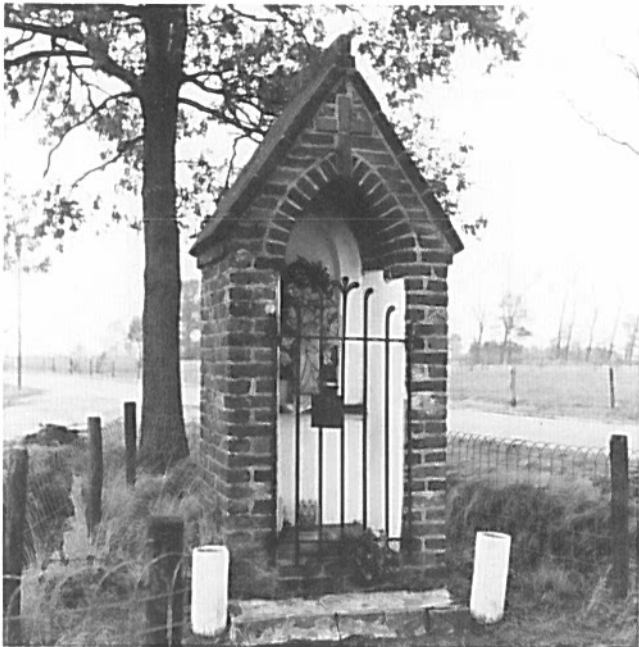
Maria-kapel aan de Booldersdijk.
